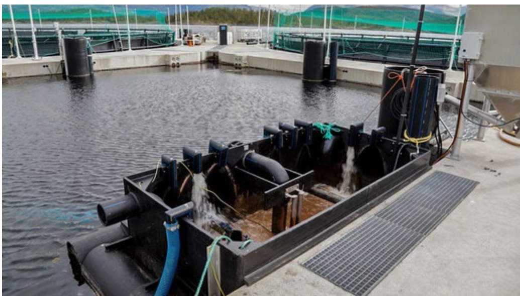
Figur 11.6. Akvafuture - slamoppsamling fra matfiskoppdrett. Foto: Akvafuture
